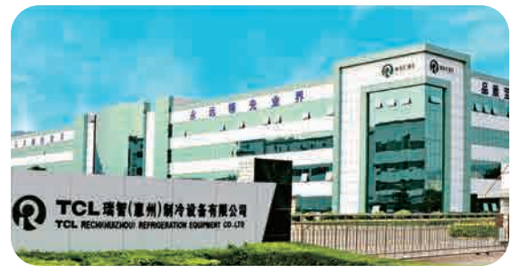
TCL-Rechi Compressor JV Хуейчжоу (16 млн. шт. компресорів)
